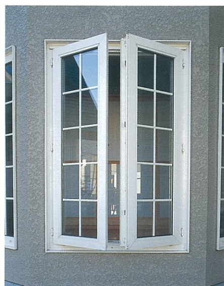
塩ビサッシ | アルミサッシと比べ、断熱効果が高い。
